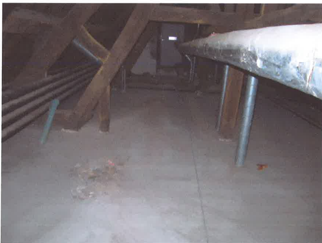
Vue sur les charpentes après la préparation des bois. Le nettoyage du chantier est réalisé avant le traitement. les déchets sont évacués du chantier dans des sacs hermétiques.
